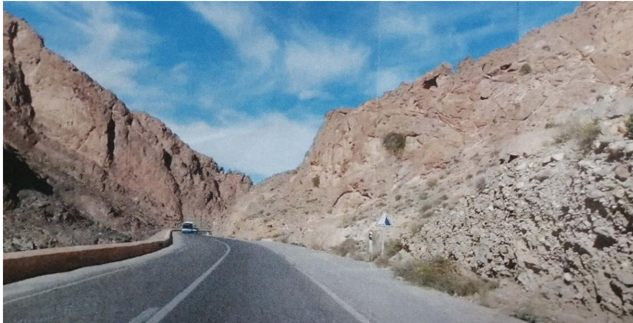
Risque de chute de blocs (PK 479) [Extrait du Rapport du BET]
