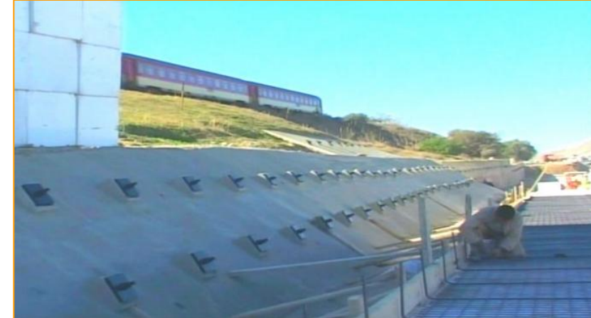
Solution de traitement du glissement au PK255 de la RN6 (Fès-Taza) : Tirants d'ancrage (talus) + remblai léger (plateforme)
