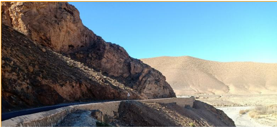
Passage de la RN13 (liaison Zaïda-Rich) : falaise rocheuse
