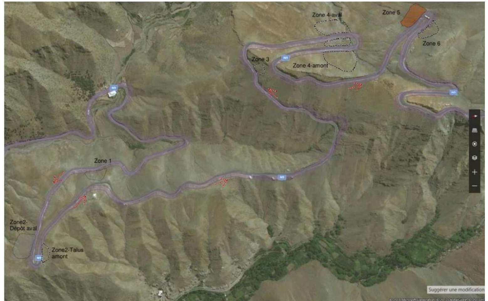
Zones d'instabilité sur le tronçon 1 de la RN9 entre Taddart2 et le col Tizi N'Tichka (sens de montée en rouge)
